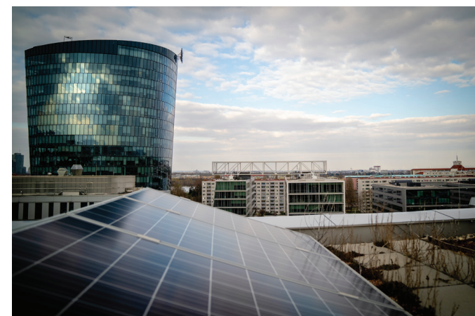
Viertel Zwei PV Anlage © Wien Energie
